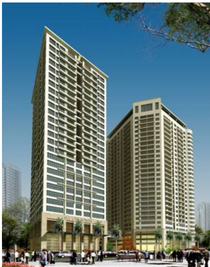
Hình 1. Khu căn hộ cao cấp SKYCITY TOWERS, 88 Láng Hạ, Hà Nội.
