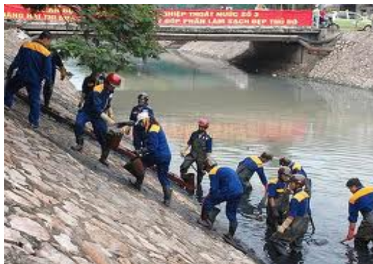
Hình 2. Nạo vét thủ công bằng xô xách bùn lắng và chất thải rắn ở đáy sông
