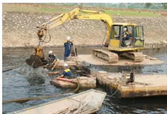
Hình 3. Nạo vét bằng máy đào đứng trên phao nổi
