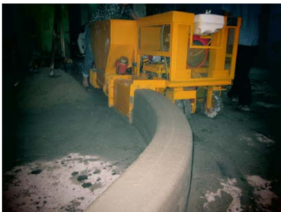
Hình 7. Hoạt động của máy đúc bó vỉa bê tông tự hành
