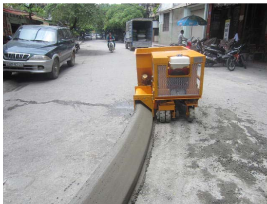
Hình 7. Hoạt động của máy đúc bó vỉa bê tông tự hành
