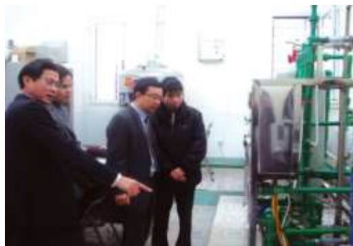
Hình 4. Tham quan hệ thống vi lọc và khử trùng, xử lý nước mưa
