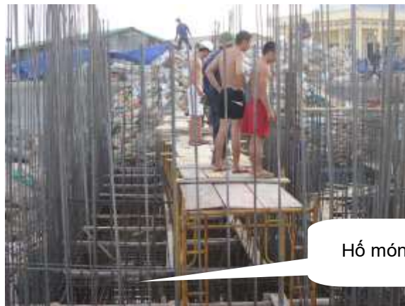
Hình 5. Vật liệu (thép) được lắp đặt trực tiếp trên đáy hố móng vẫn còn nước biển, là nguồn gây ăn mòn rất mạnh
