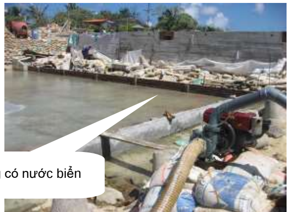
Hình 5. Vật liệu (thép) được lắp đặt trực tiếp trên đáy hố móng vẫn còn nước biển, là nguồn gây ăn mòn rất mạnh
