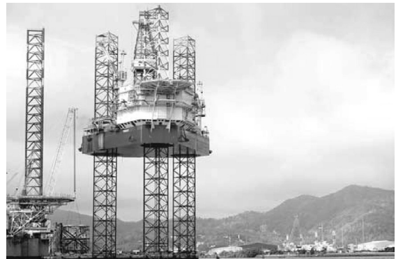
Hình 1. Hình ảnh thực tế của kết cấu giàn tự nâng 400 ft
