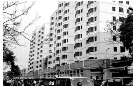
Hình 3. Chung cư B7 - Kim Liên được xây trên nền khu tập thể Kim Liên cũ
