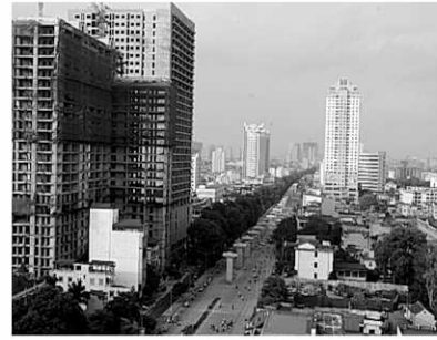
Hình 2. Những tuyến đường bộ, đường sắt trên cao đã và đang được thi công
