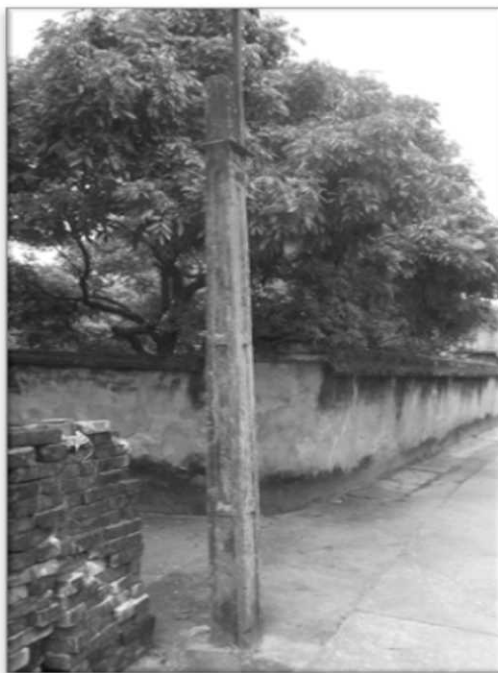
Hình 7. Hệ thống hạ tầng được xây dựng đầu thế kỷ XX tại làng Cự
