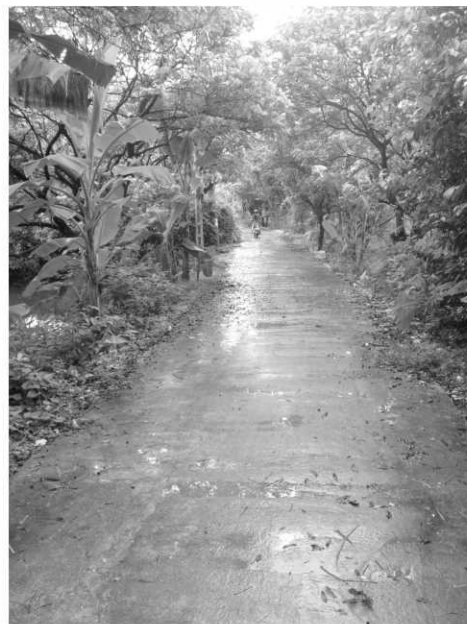
Hình 1. Đường trục chính thôn Nha Xá, xã Mộc Nam, huyện Duy Tiên. Sau khi cải tạo rộng 2,5 m, đủ cho 1 làn xe, không có rãnh thoát nước 2 bên
