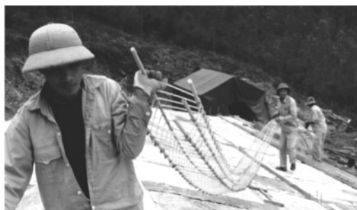
Hình 4. Thép polyme được sử dụng tại một hạng mục thuộc khu tưởng niệm Đại tướng Võ Nguyên Giáp, Vũng Chùa - Quảng Bình
