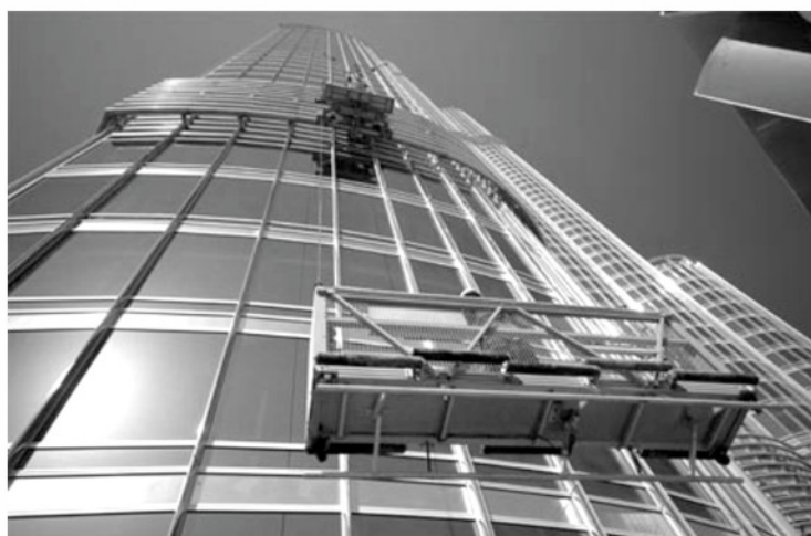
Hình 5. Bảo trì kính bao che tòa nhà Burj Khalifa
