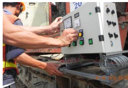
Hình 8. Sản phẩm phiên bản mới nhất lắp ráp tại công trường
