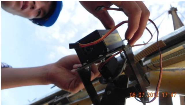
Hình 3. Lắp ráp cảm biến la de tại công trường
