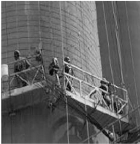
a) Gia cố lỗ silo
