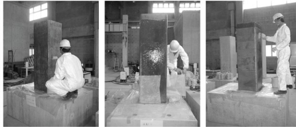
a) Lăn epoxy lên bề mặt cột b) Bó tấm FRP lên cột c) Sau khi bó xong
