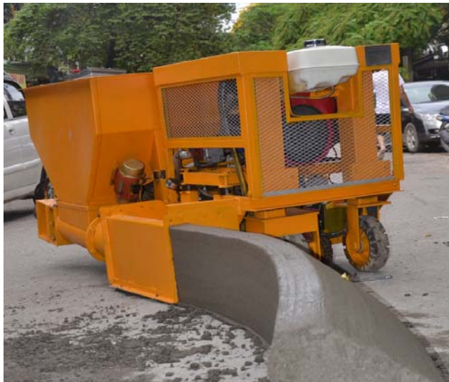
Hình 3. Thi công đúc bó vỉa bê tông bằng máy BV-60
