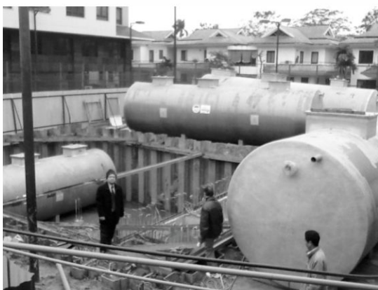
Hình 2. Lắp đặt các bể xử lý nước thải tại công trường
