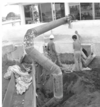
Hình 5. Cải tạo các bể lọc Nhà máy Nước An Dương thành bể lọc hai lớp vật liệu
