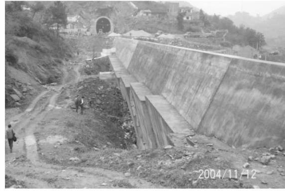
Hình 2. Tường chắn tuyến Thành Đô - Trùng Khánh, tỉnh Tứ Xuyên, Trung Quốc
