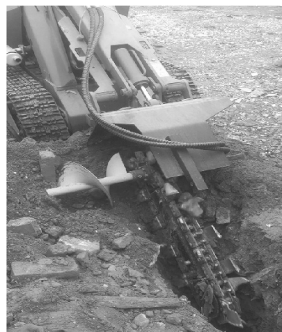
Hình 6. Máy ĐRH-01 đang thi công
