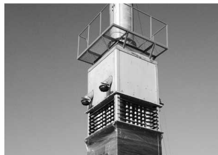
Hình 3. Cán bộ tiến hành đo, lấy mẫu, quan trắc mẫu khí tại hiện trường, vị trí lắp thiết bị làm lạnh nhanh khí thải
