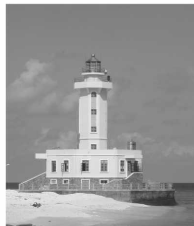
Hình 7. Công trình trọng lực đỡ đèn biển ven đảo Trường Sa Lớn
