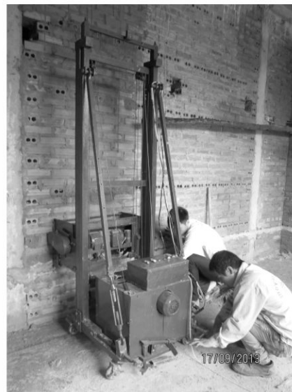
Hình 8. Máy trát cùng cụm trát miết rung do nhóm tác giả bài báo thiết kế chế tạo
