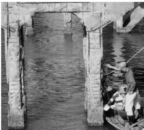
Hình ảnh cốt thép cho kết cấu bê tông theo thời gian trong điều kiện môi trường vùng ven biển và thanh cốt sợi Polyme GFRP đường kính tới 20mm
