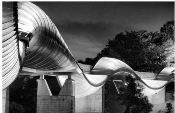
Hình 2. Cầu - không gian công cộng
