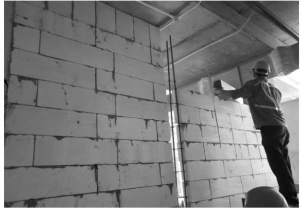
Tường trong nhà cao tầng
