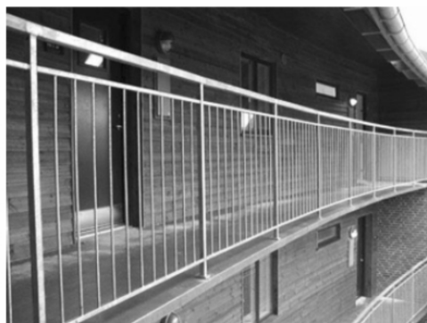
Hình 6. Hành lang từ UHPC Storm Surge ở Hà Lan [Buitelaar P. 2004]
