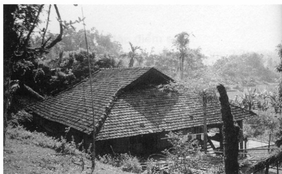
Hình 7. Mái nhà có độ dốc lớn để tăng khả năng thoát nước [5]
