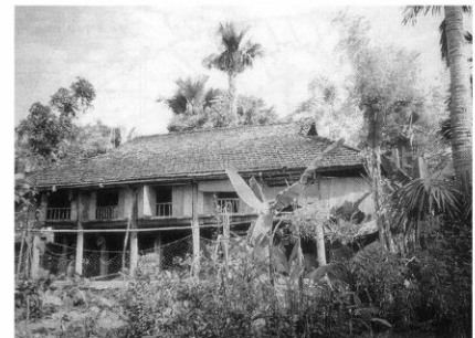
Hình 6. Nhà có cấu tạo mái dày, tường xung quanh và sàn bằng tre hoặc gỗ thoáng hờ để tận dụng tốt điều kiện khí hậu tự nhiên, tránh nắng và mưa hắt [5]
