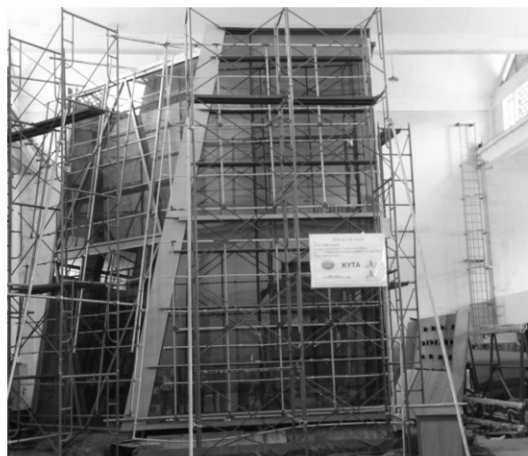
Hình 1. Thí nghiệm vách kính tại Viện Khoa học Công nghệ Xây dựng tháng 9/2014
