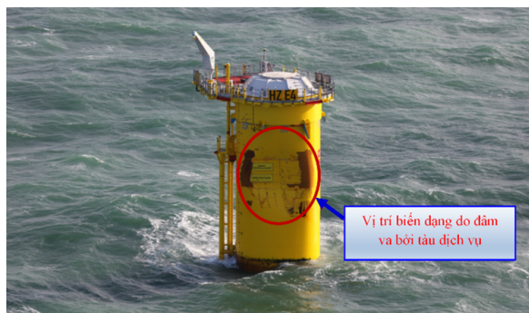
Hình 3. Vị trí hư hỏng của chân đế khi bị đâm va bởi tàu dịch vụ ở vùng biển Hollandse Kust Zuid, Hà Lan [10]
