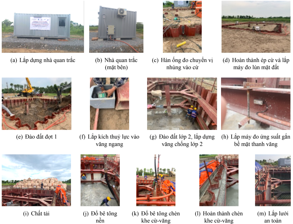
Hình 5. Quá trình thi công lắp dựng trên hiện trường
