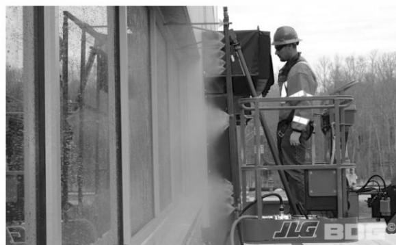
Hình 9. Kiểm tra khả năng chống lọt nước tại một công trình
