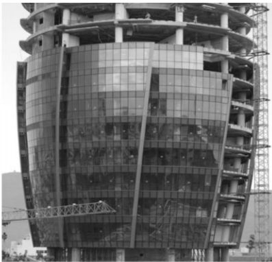
a. Lắp dựng theo modul
