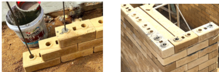
Hình 2. Minh họa thi công sườn đứng [1]
