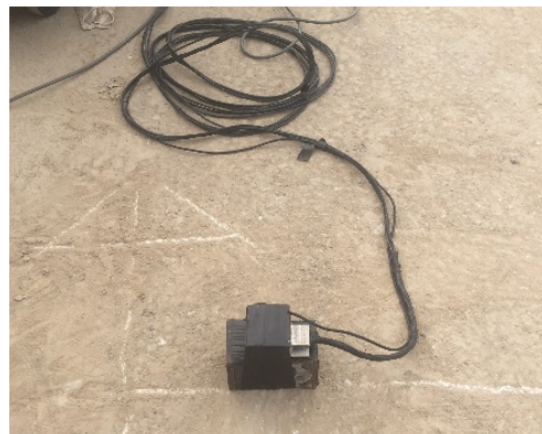
Hình 8. Đầu đo gia tốc 3 phương trên kết cấu nhíp
