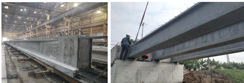
Hình 5. Chế tạo và lắp đặt dầm I-UHPC 21 m cầu An Thượng [11]
