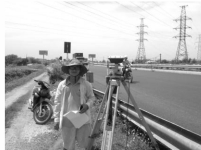
b. Sử dụng GPS đo lưới khống chế thi công
