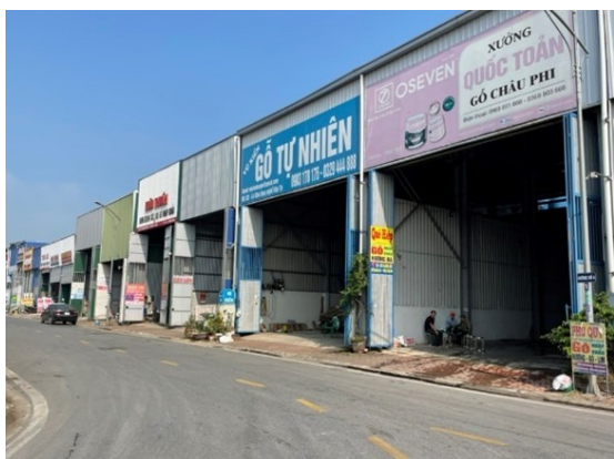
(a) Công trình tại CCN làng nghề Văn Tự
