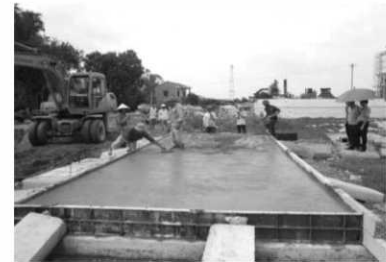
Hình 8. Thi công mẫu hiện trường
