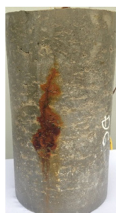
(a) Vị trí nứt trên bê tông
