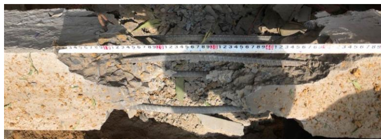
(c) Cấu kiện BTCT số 5
