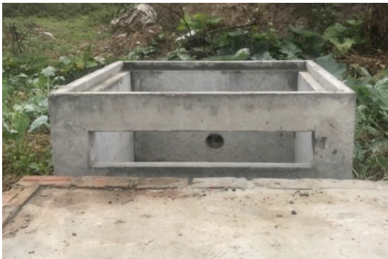
(a) Lắp đặt hố trồng cây tại hiện trường
