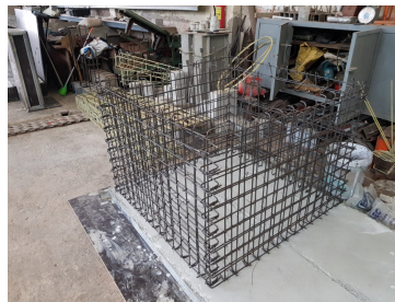
(b) Gia công cốt thép
