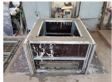
(c) Đổ bê tông
